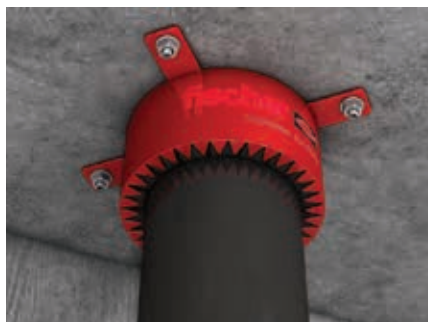
Aplikácia do stropu
