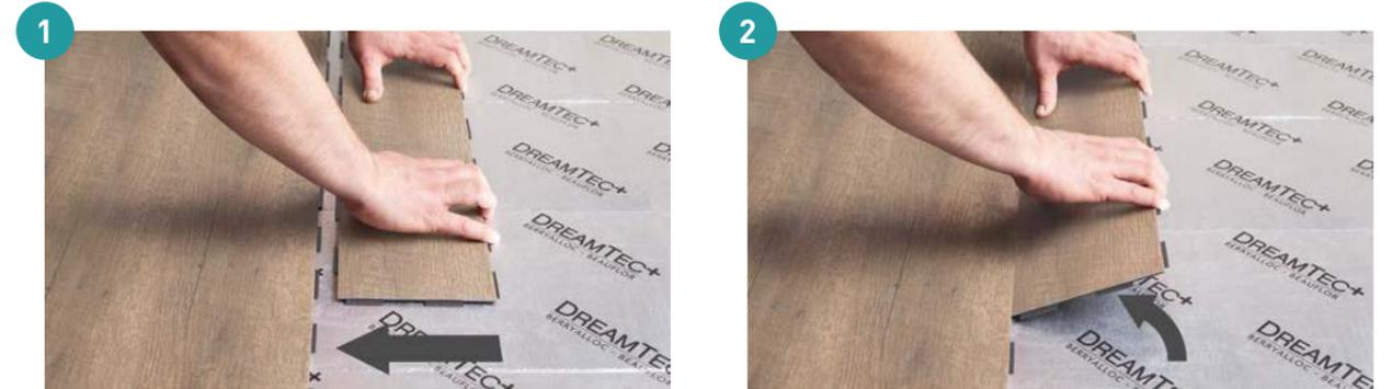
1 Fügen Sie die Dielen zusammen, indem Sie diese flach auf dem Boden aneinanderlegen und zusammenschieben, sodass die Verbinder ineinandergreifen.
