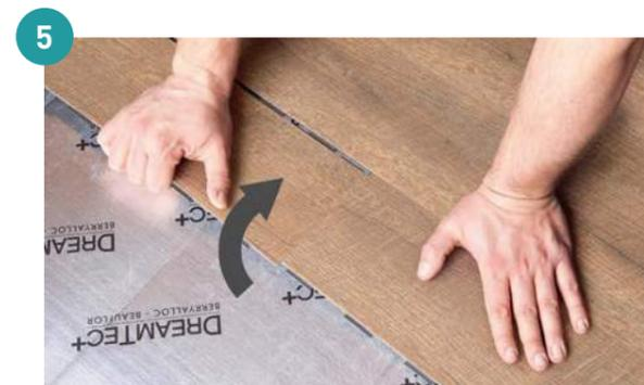
5 Verbinden Sie die kurzen Seiten so, dass die Verriegelung ineinandergreift, schieben Sie die lange Seite in die zuvor verlegte Reihe, heben Sie die Diele leicht an, klicken und ablassen.
