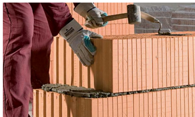
Murovanie klasických tehál na klasickú vápenocementovú maltu
