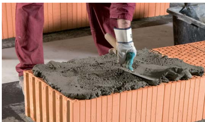
Murovanie klasických tehál na klasickú vápenocementovú maltu
