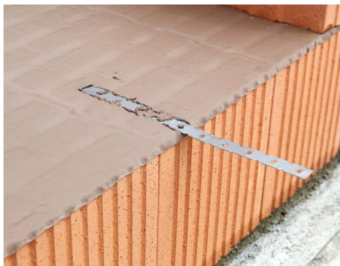
Osadenie stenovej spony do ložnej škáry v murive z tehál Porotherm T Profi
