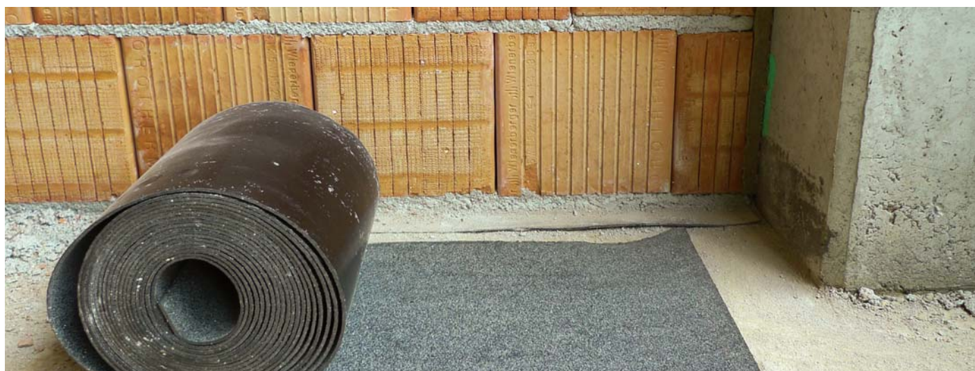
Akustické deliace steny je potrebné oddeliť od ostatných častí stavby aby sme zabránili prenosu zvuku vedľajšími cestami - založenie prvého radu na ťažký asfaltový pás
