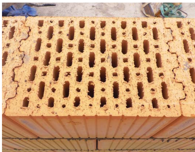
Ďalšou zásadou pre murovanie akustických deliacich stien sú tesné styčné škáry bez akejkoľvek medzery - príklady muriva z tehál Porotherm 25 AKU Z (vľavo) a Porotherm 30 AKU Z (vpravo)
