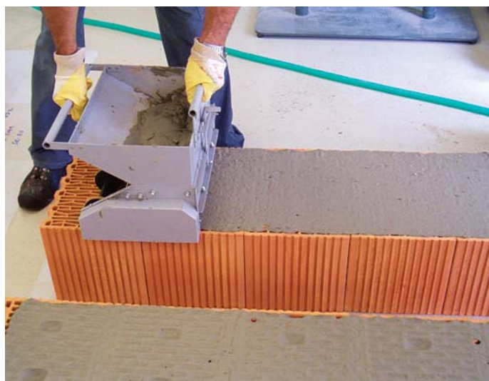
Celoplošný spôsob nanášania malty Porotherm Profi pomocou špeciálneho nanášacieho valca
