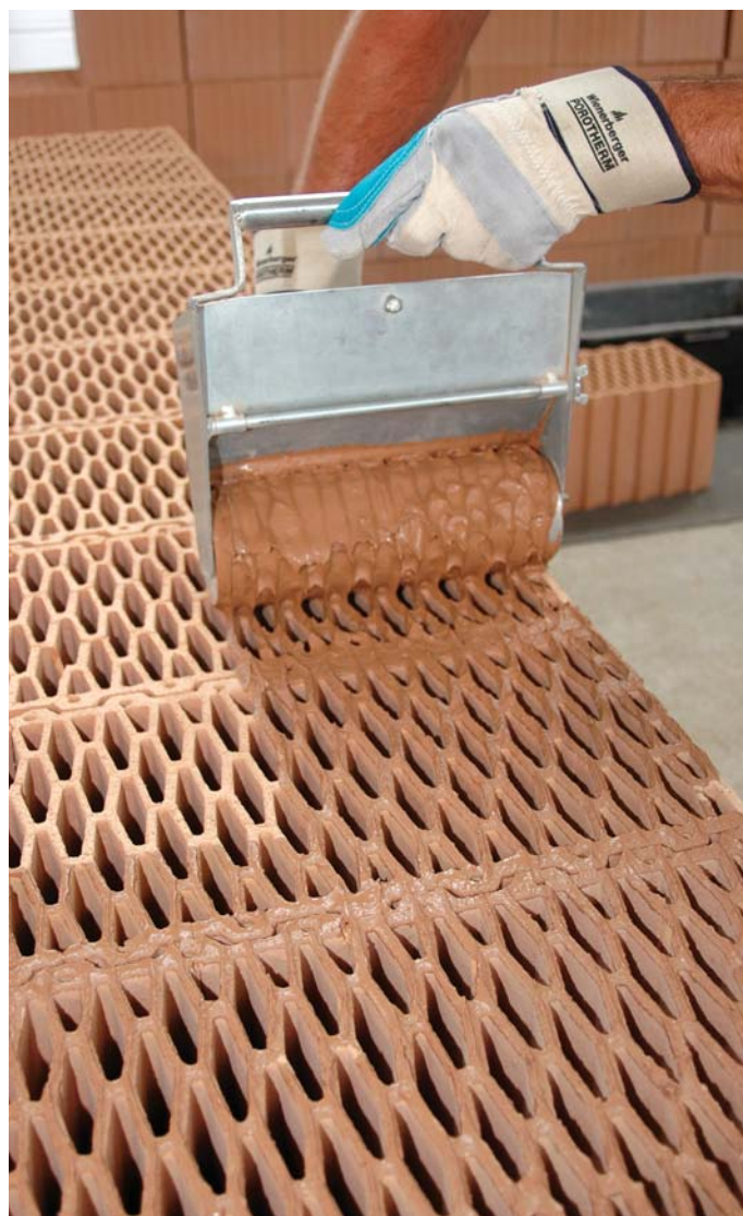
Kontaktný spôsob nanášania malty PoroTherm Profi pomocou nanášacieho valca
