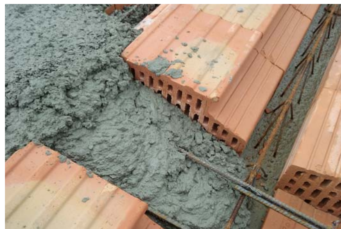
Detail stropu počas betonáže
