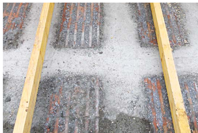
Detail stropu Porotherm bez nadbetonávky po betonáži
