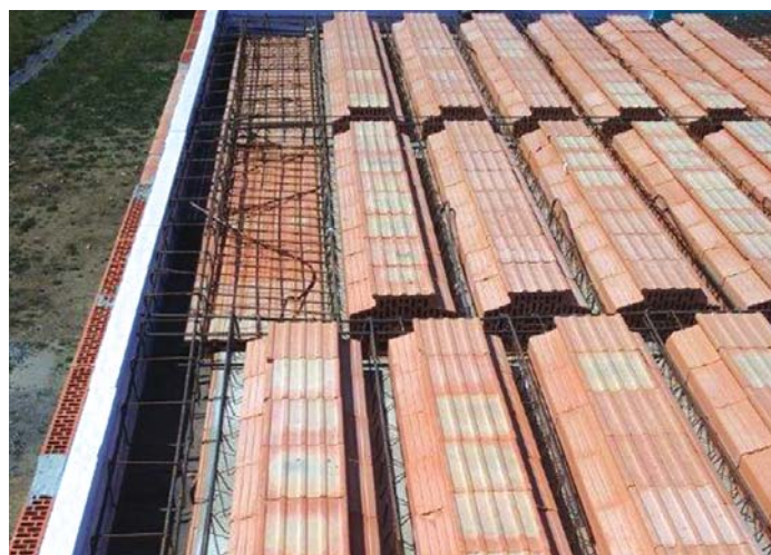
Detaily stropu Porotherm bez nadbetonávky pred betonážou
