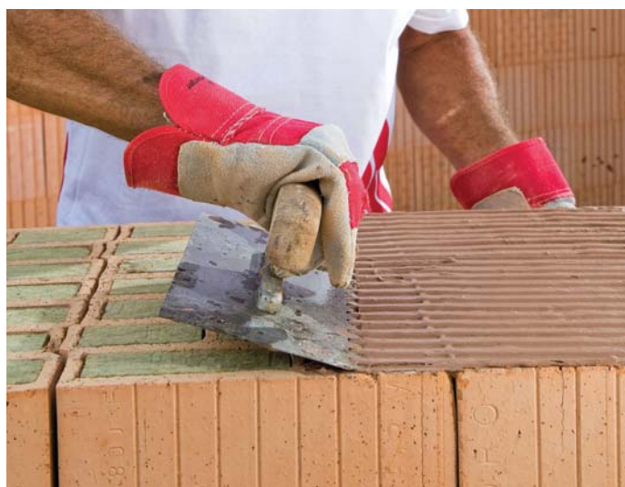
Nanášanie malty Porotherm Profi na brúsené tehly plnené minerálnou vlnou je možné aj pomocou hrebeňového hladidla
