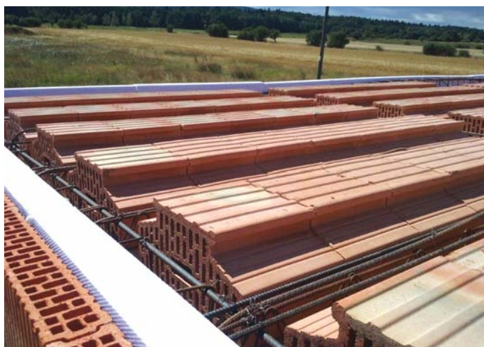
Detaily stropu Porotherm bez nadbetonávky pred betonážou
