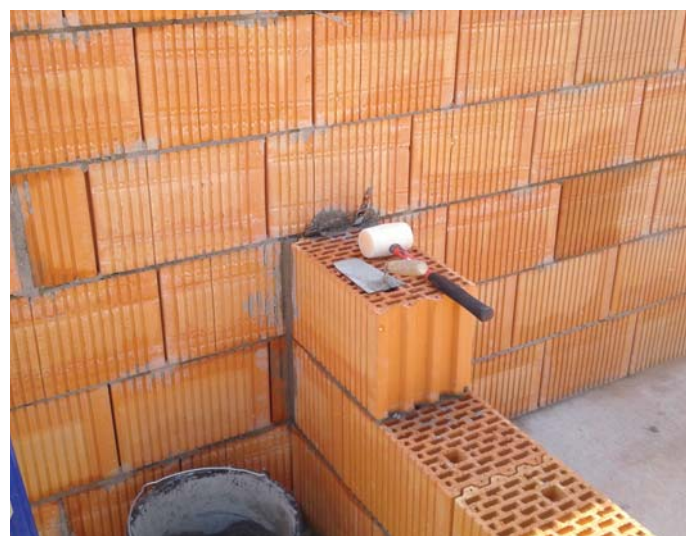
Napojenie stien pomocou stenových spojů (škára v mieste napojenia vyplnená maltou)
