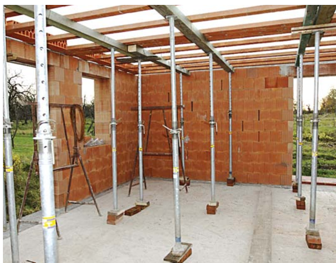
Uložené a podopreté nosníky Porotherm KPSN
