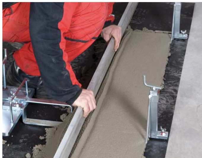
Nanášanie maltového lôžka zo základacej malty PoroTherm AM
