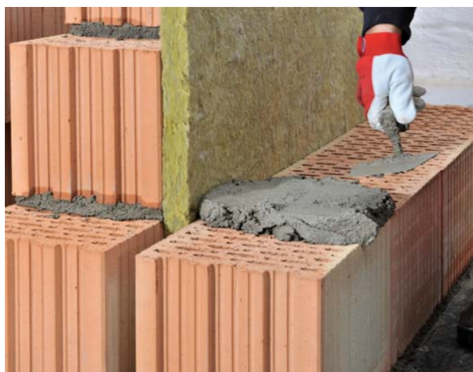
Murovanie na vápenno-cementovú maltu Porotherm MM50
