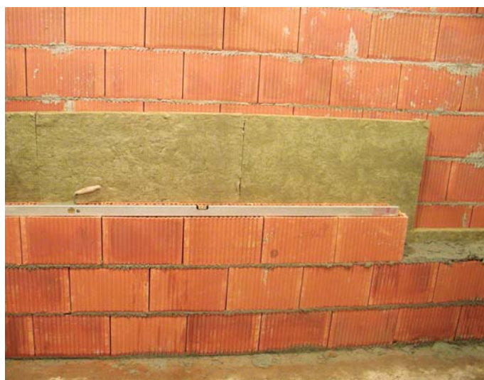
Na oddelenie bytov v radových domoch alebo dvojdomoch je potrebné použiť dvojitú stenu s medzerou vyplnenou vhodnou zvukovoizolačnou vrstvou
