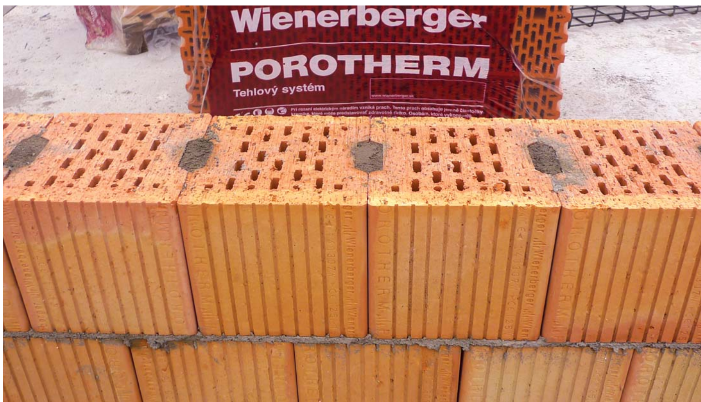
Murivo z tehál Porotherm 30 AKU MK - maltové kapsy v každom rade tehál treba dôkladne vyplniť murovacou maltou
