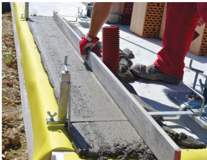
Nanášanie maltového lôžka zo základacej malty PoroTherm AM
