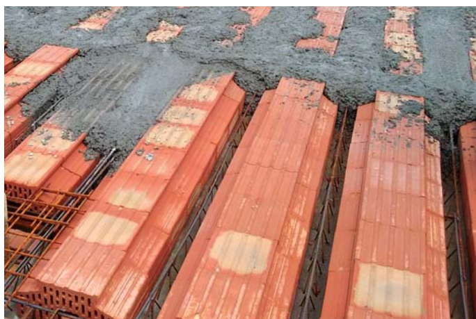
Betonáž stropu - zaliatie nosníkov s priestorovou výstužou po horný okraj stropných vložiek
