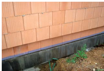
Soklové tehly Porotherm TS Profi v prvom rade obvodového muriva z tehál Porotherm T Profi. Impregnácia spodnej časti tehál bráni vzlínaniu dažďovej vody stojacej na základovej doske počas výstavby.
