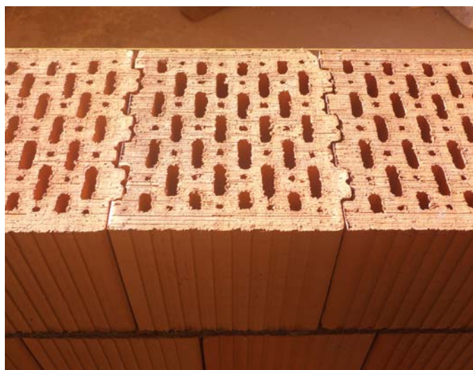
Ďalšou zásadou pre murovanie akustických deliacich stien sú tesné styčné škáry bez akejkoľvek medzery - príklady muriva z tehál Porotherm 25 AKU Z (vľavo) a Porotherm 30 AKU Z (vpravo)
