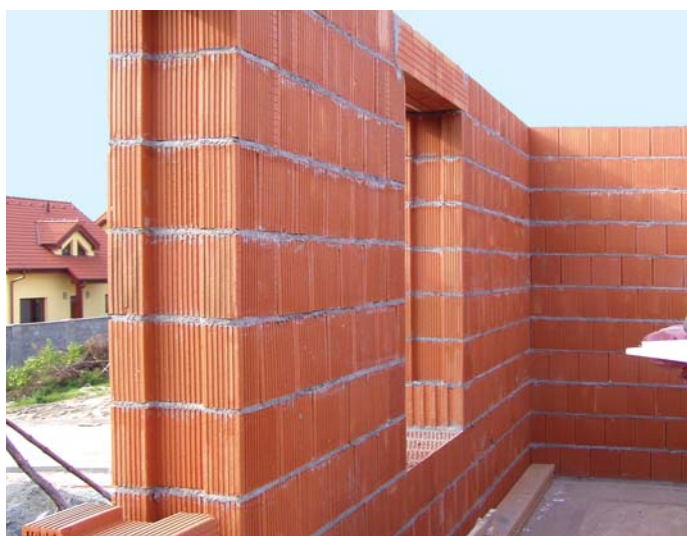
Aj ku klasickým tehálam sú doplnkové formáty určené na zhotovenie ostien a parapetov okien
