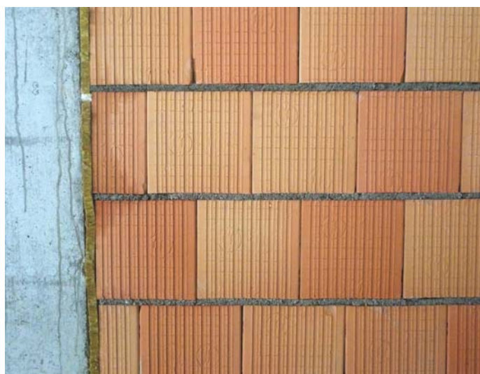
Jeden z možných riešení zvislého napojenia akustickej deliacej steny na na betónový stĺp - medzera dôkladne vyplnená minerálnou vlnou
