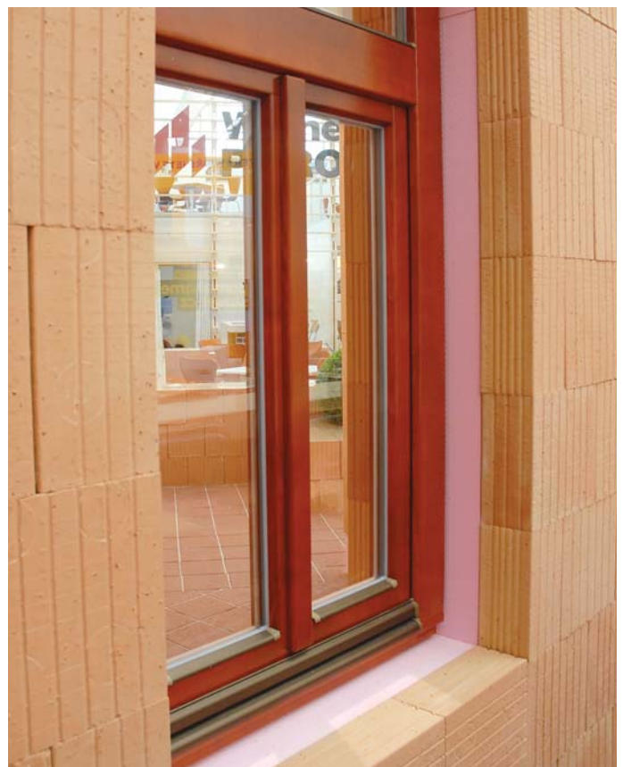
Príklady použitia koncových tehál Porotherm EKO+ Profi K a 1/2 K v ostení a parapete okna
