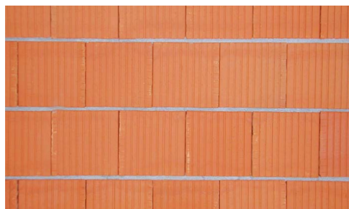
Detail muriva z klasických tehál na klasickú maltu - vzorne premaltované ložné škáry
