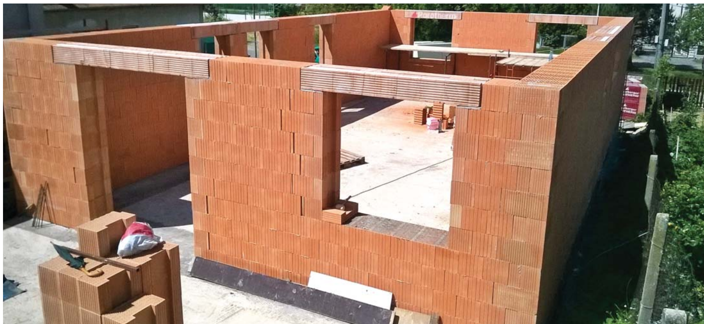
Hrubá stavba s osadenými prekladmi Porotherm KP 7
