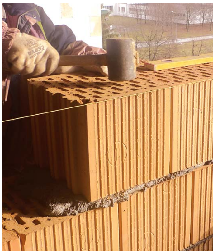
Murivo z tehál Porotherm 30 AKU Z - pri murovaní akustických deliacích stien je dôležitou zásadou úplné premaltovanie ložnej škáry od jedného líca muriva k druhému
