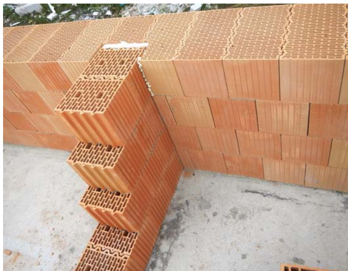
Príklad napojenie vnútornej nosnej steny na obvodovú stenu
