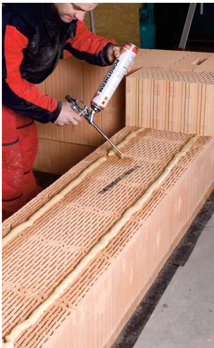
Nanášanie murovacej peny PoroTherm Dryfix extra pomocou aplikačnej pištole; osadenie stenovej spony do lôžnej škáry
