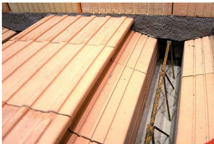
Detail stropu pred betonážou
