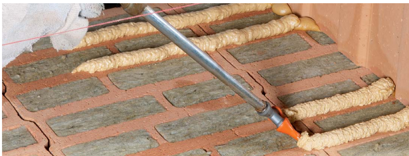
Nanášanie murovacej peny Porotherm Dryfix extra na tehly Porotherm T profi pomocou aplikačnej pištole
