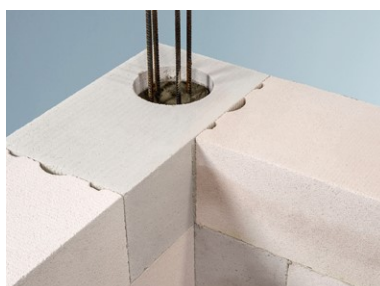
Vymurované a vybetónované dve vrstvy
