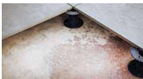
POKLÁDKA NIVELIZAČNÝM SYSTÉMOM
