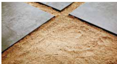
POKLÁDKA DO PIESKOVÉHO LÔŽKA
