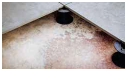
POKLÁDKA NIVELIZAČNÝM SYSTÉMOM
