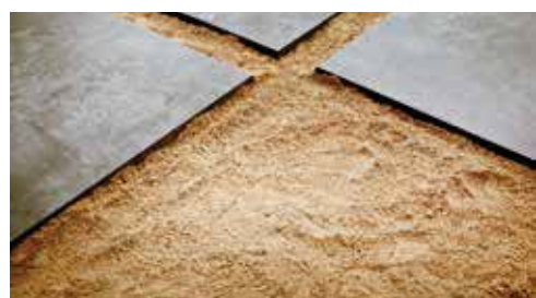
POKLÁDKA DO PIESKOVÉHO LÔŽKA
