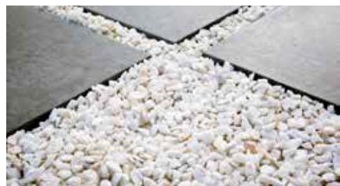
POKLÁDKA DO ŠTRKOVÉHO LÔŽKA
