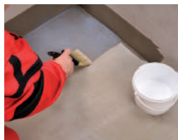
2 / Napenetrujeme podklad a zjednotíme nasiakavosť.
