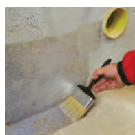
2 / Napenetrujeme podklad a zjednotíme nasiakavosť.
