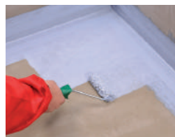
7 / Celoplošne naniesieme prvú vrstvu.
