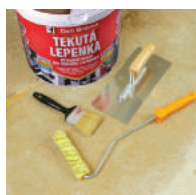
8 / Pripravíme si náradie – valček, štetec, oceľové hladítko.
