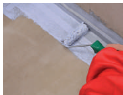
6 / Vtlačíme valčekom Tesniacie pásy do zvislých a vodorovných kútov.
