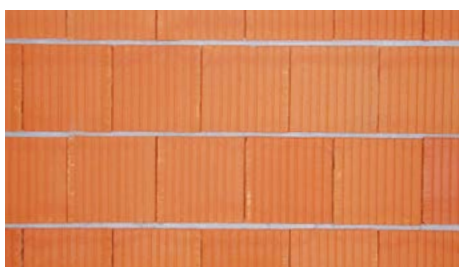
Detail muríva z klasických tehál na klasickú maltu (vzorovo premaltované ložné škáry)
