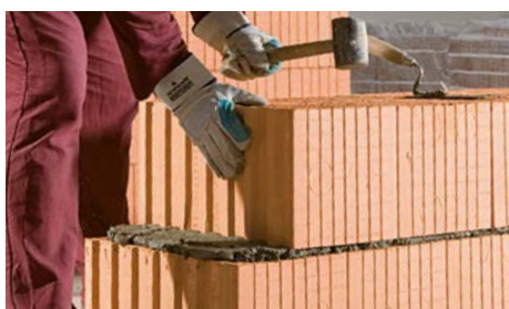
Murovanie klasických tehál na klasickú vápenocementovú maltu
