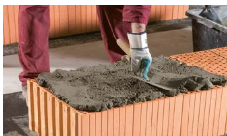
Murovanie klasických tehál na klasickú vápenocementovú maltu
