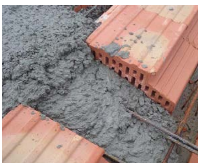
Detail stropu počas betónáže
