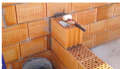
Napojenie stien pomocou stenových spôn (škára v mieste napojenia vyplnená maltou)
