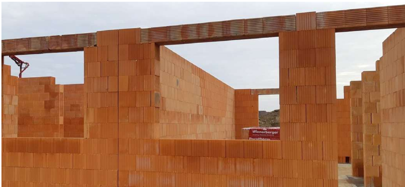
Hrubá stavba s osadenými prekladmi Porotherm KP 7
