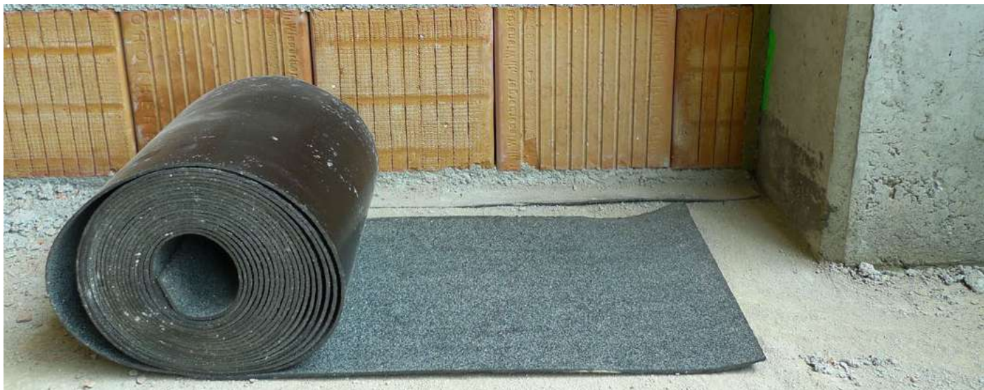
Akustické deliace steny je potrebné oddeliť od ostatných častí stavby, aby sme zabránili prenosu zvuku vedľajšími cestami - založenie prvého radu na ťažký asfaltový pás
