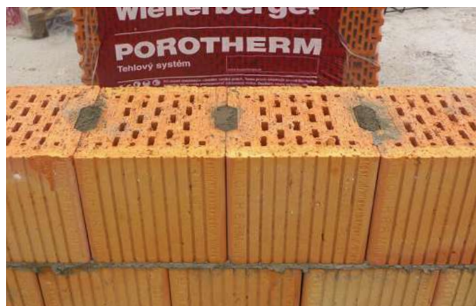
Ďalšou zásadou pre murovanie akustických deliacich stien sú tesné styčné škáry bez akejkoľvek medzery - vľavo: murivo z tehál Porotherm 25 AKU Z, vpravo: murivo z tehál Porotherm 25 AKU MK - maltové kapsy v každom rade tehál treba dôkladne vyplniť murovacou maltou.
