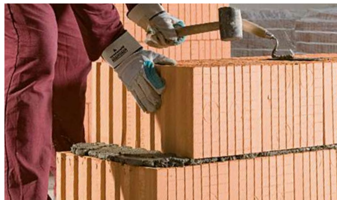
Murovanie klasických tehál na klasickú vápenocementovú maltu
