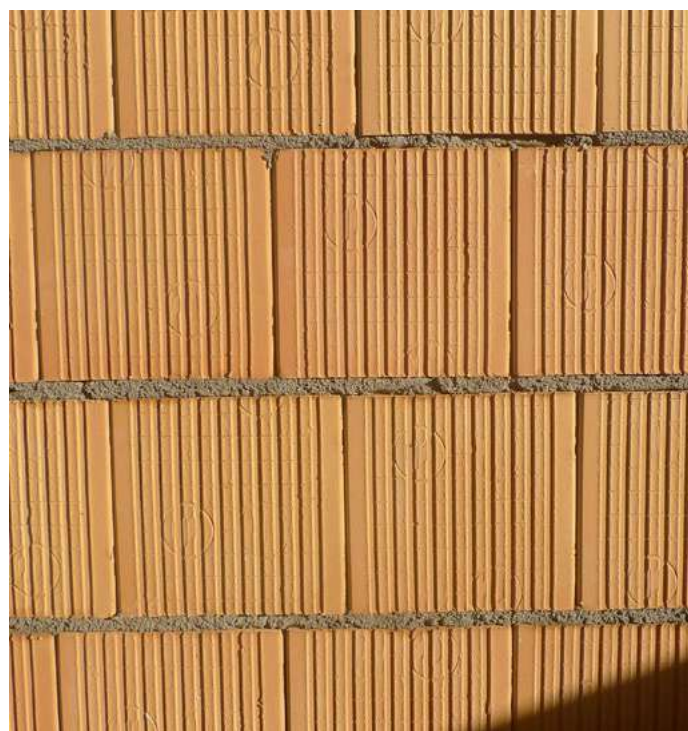
Vzorne vymurovaná akustická deliaca stena
