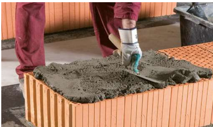
Murovanie klasických tehál na klasickú vápenocementovú maltu
