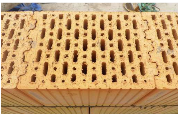
Ďalšou zásadou pre murovanie akustických deliacich stien sú tesné styčné škáry bez akejkoľvek medzery - vľavo: murivo z tehál Porotherm 25 AKU Z, vpravo: murivo z tehál Porotherm 25 AKU MK - maltové kapsy v každom rade tehál treba dôkladne vyplniť murovacou maltou.
