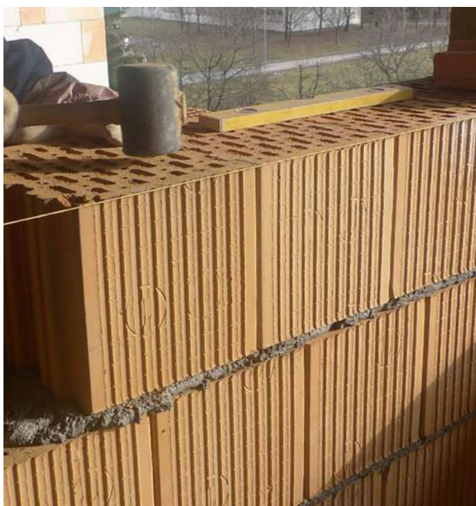
Murivo z tehál Porotherm 30 AKU Z - pri murovani akustických deliacich stien je dôležitou zásadou úplné premaltovanie ložnej škáry od jedného lica muriva k druhému
