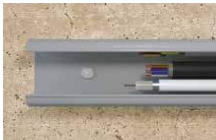
Upevňovanie káblových žlabov
