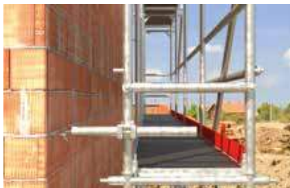
Kotvenie fasádneho lešenia
