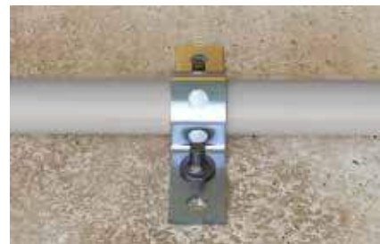
Ukotvenie dierovaných pásov
