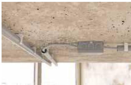
Upevnenie plastových izolačných trubiek
