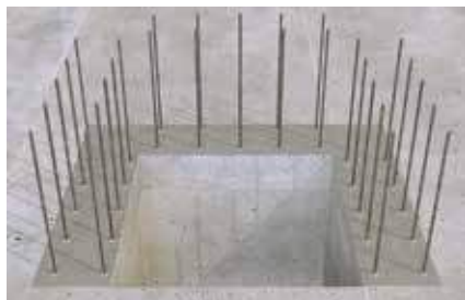
Dodatočne vlepené betonárske výstuže
