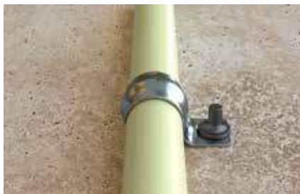
Ukotvenie opláštených trubiek
