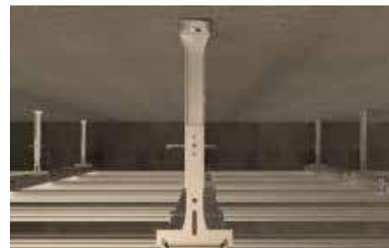
Podhľady upevnené na závesoch Nonius
