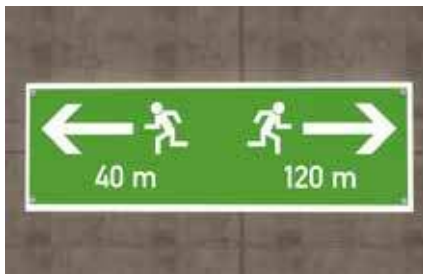
Značky núdzových východov v tuneloch
