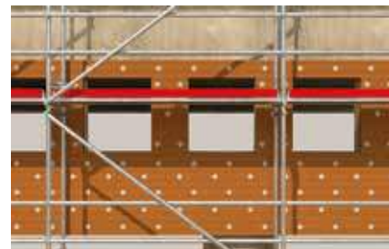
Tlakovo odolné izolačné materiály v závesových fasádach
