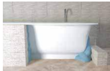
Izolácia kúpeľňových vaní a sprchovacích kútov
