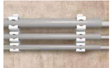
Upevnenie plastových izolačných trubiek
