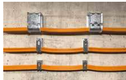
Upevnenie kábla na stenu
