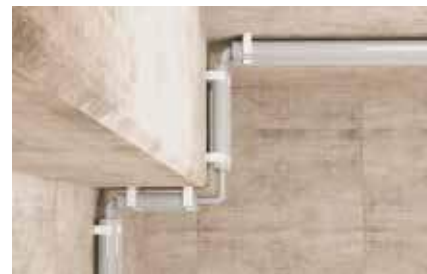
Upevnenie plastových izolačných trubiek
