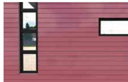
Nosné konštrukcie fasád
