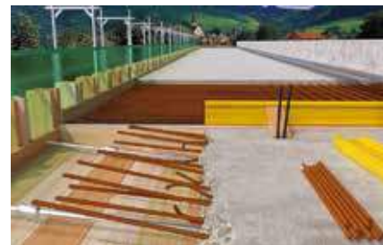
Vlepované betonárske výstuže
