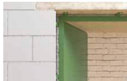
Vyplňovanie dutín v izolácii
