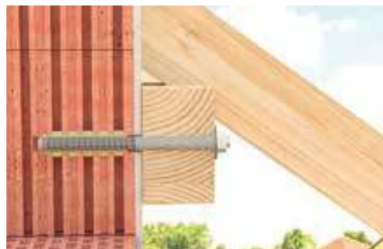
Detail: Drevené konštrukcie s prievlačnou inštaláciou
