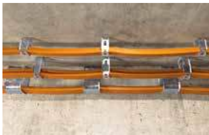
Upevnenie kábla na strop
