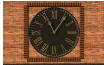
Opravy lícového muriva
