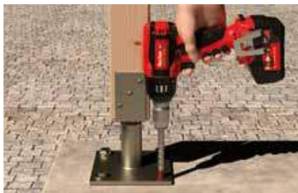
Pätky drevených konštrukcií
