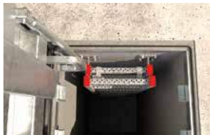
Vstup do prepadovej dažďovej nádrže
