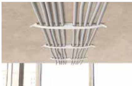
Upevnenie káblových zväzkov
