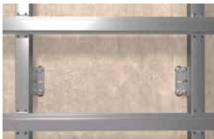
Nosné konštrukcie fasád
