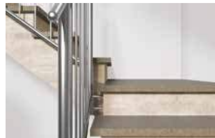
Schodnice na betónových konštrukciách
