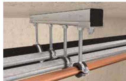
Ľahké, zavesené potrubia
