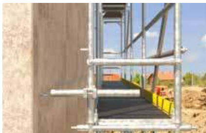
Kotvenie fasádneho lešenia
