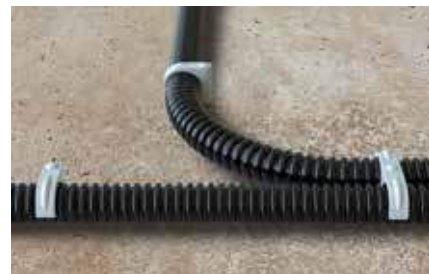
Upevnenie flexibilných trubíc
