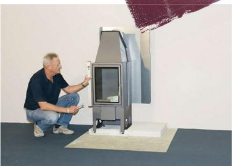
Osadte krbovú vložku pomocou vodováhy. (3)
