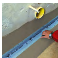
10 / Do prvého náteru vtláčime Tesniace pásy a rohy.
