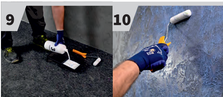
9 NATURAL aplikácia uzatváracej vrstvy
